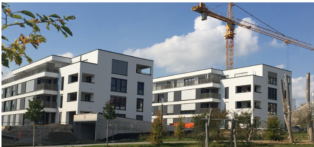
Der letzte Neubau der WOGÉ in Renningen
