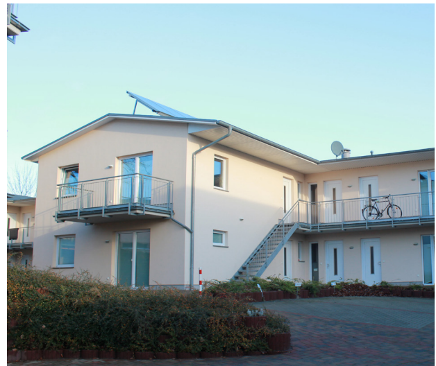
Ein fertiggestelltes Haus mit Mitarbeiterwohnungen
